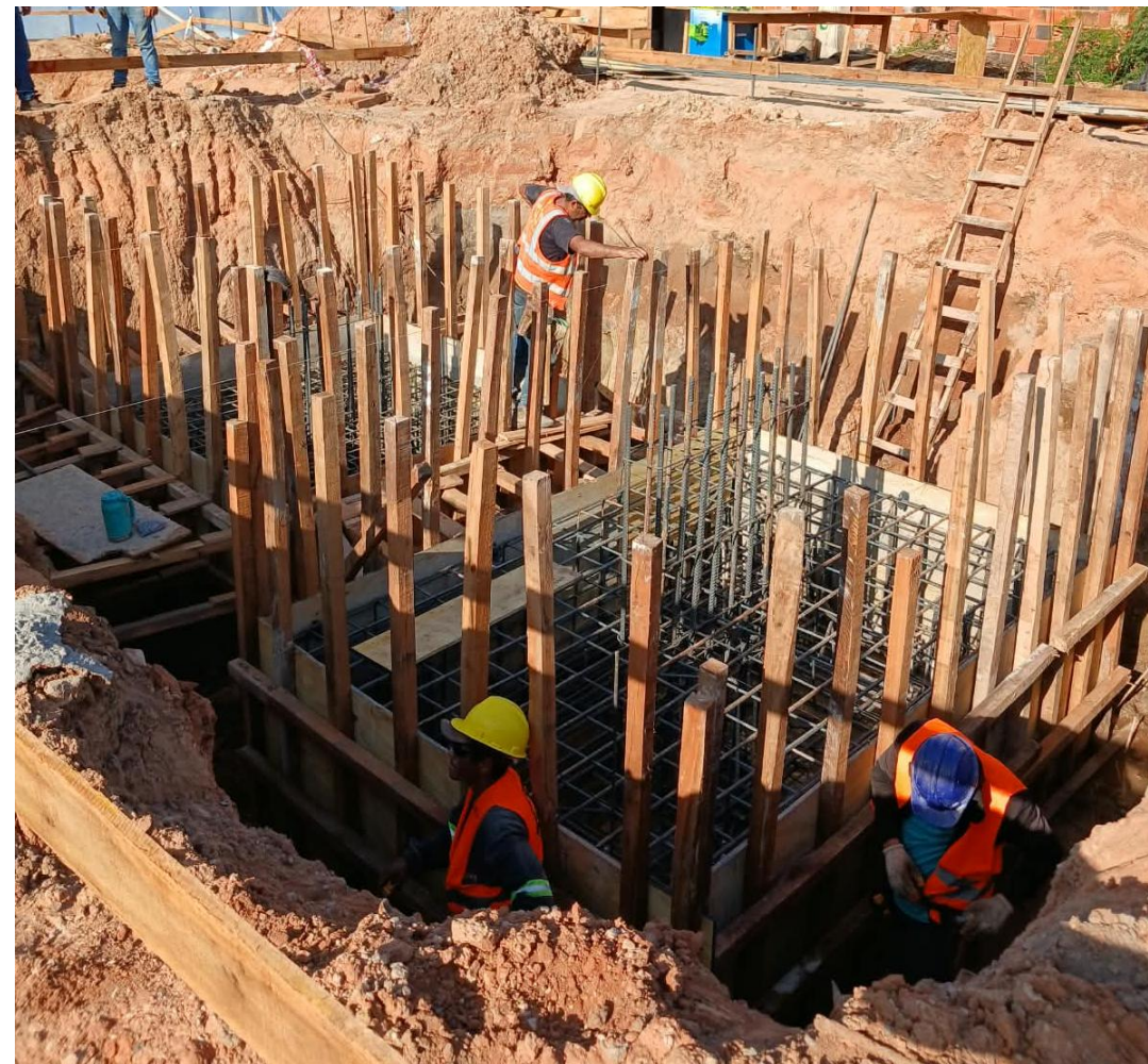
Preparación de armaduras y encofrado para cabezales de Torre 26
