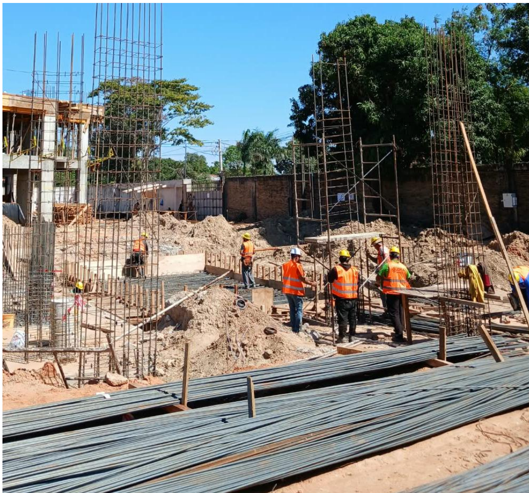
Trabajos de armado de pilares de Planta baja en Torre 25
