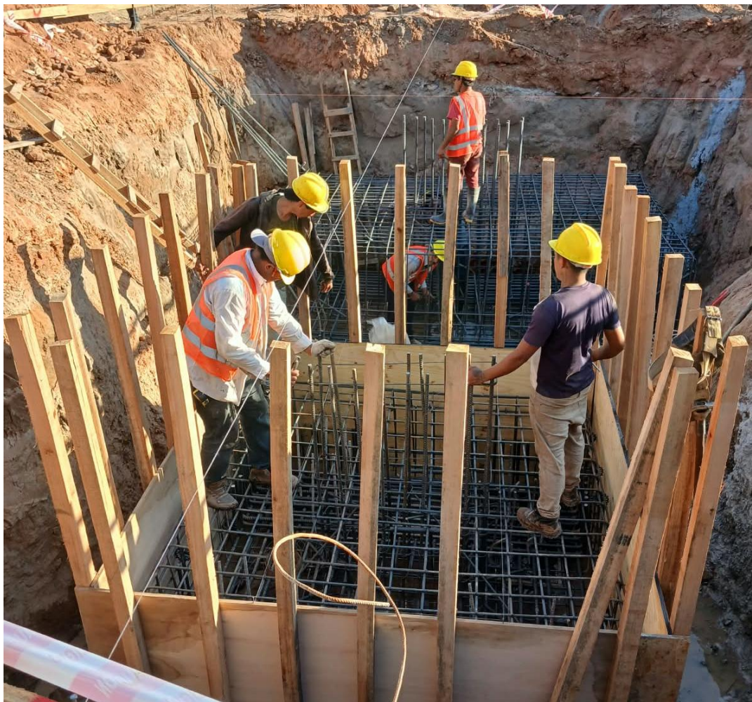
Preparación de armaduras y encofrado para cabezales de Torre 26
