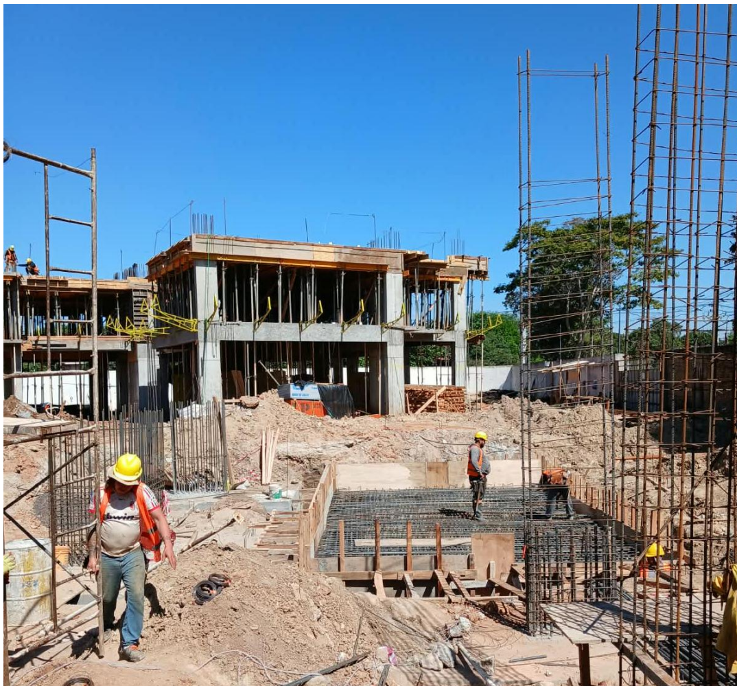
Trabajos de preparación de cabezales en Torre 25
