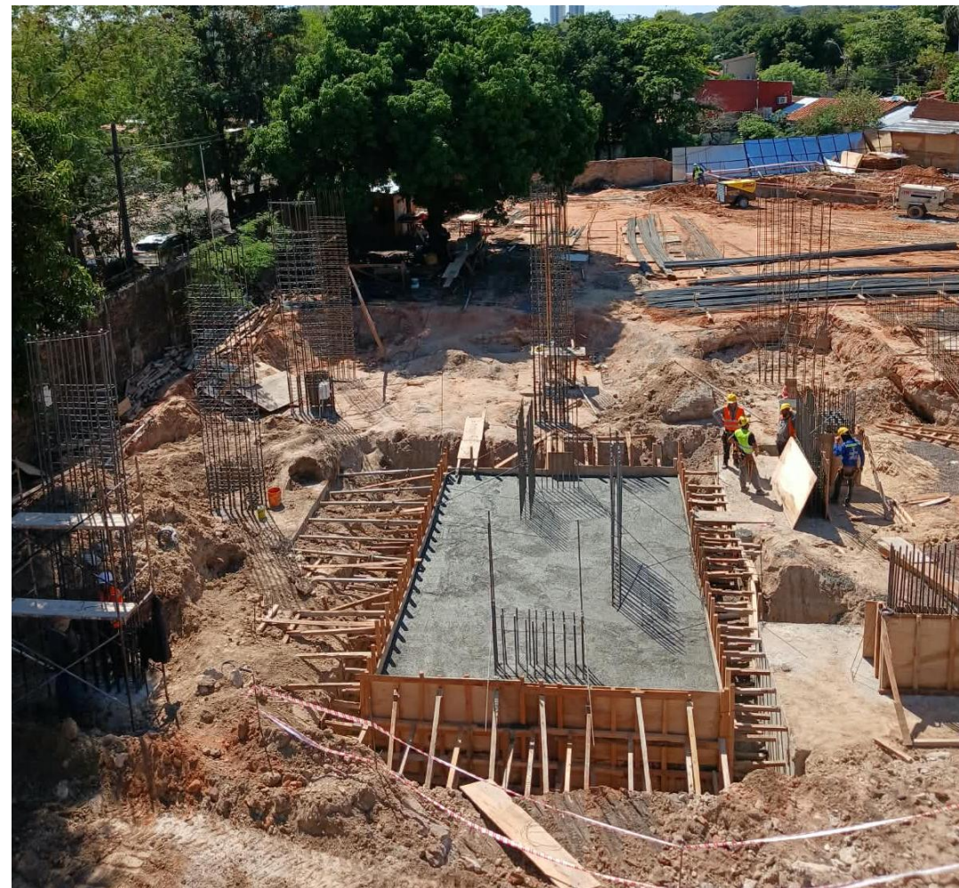
Trabajos de preparación de cabezales en Torre 25
