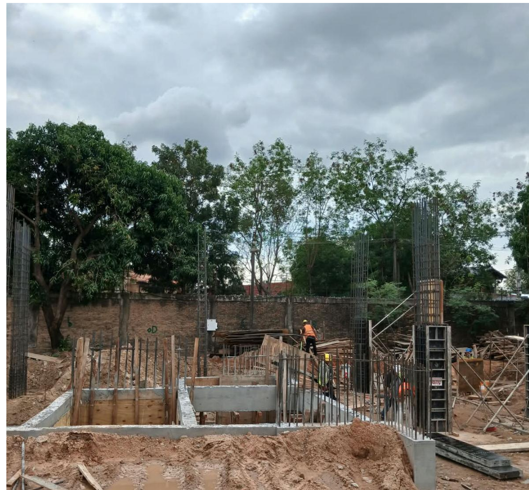
Trabajos de armado de pilares de Planta baja en Torre 25
